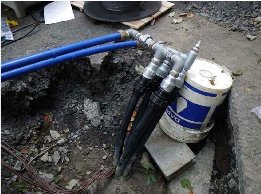
写真 4-5-8 地中熱交換器接続状況
