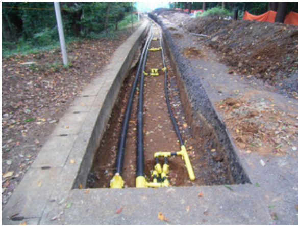
地中熱交換器設置状況
