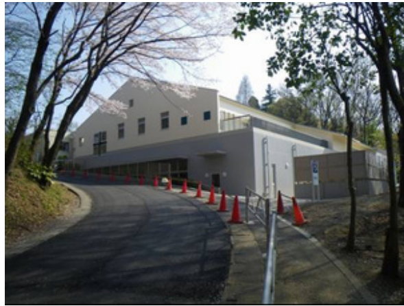
屋内プール棟の外観
