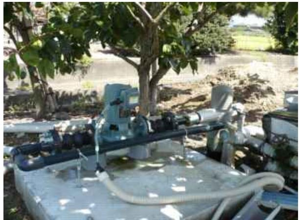
図 3-5 地下水の自噴井と循環ポンプ
