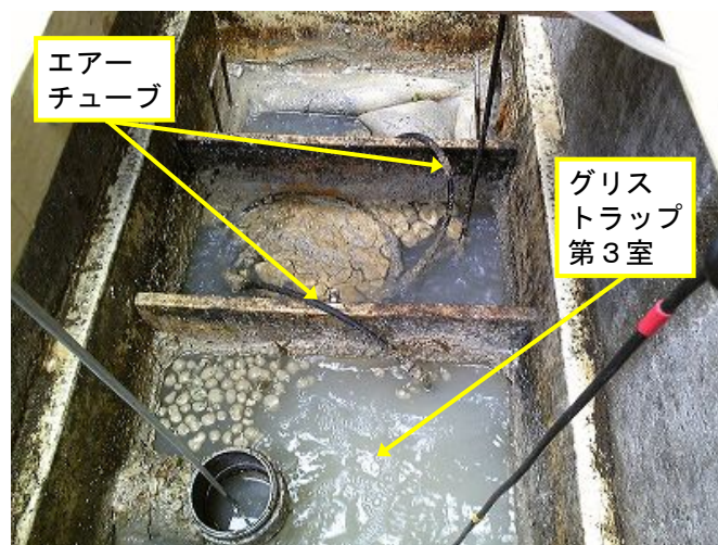
図 6 - 12 実証対象機器の設置後におけるグリストラップの状況
