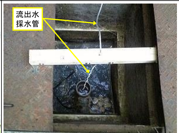
(6) グリストラップからの流出水採水場所 [ばっ気停止中で、グリストラップへの流入水(厨房からの排水)がある厨房業務中。]
