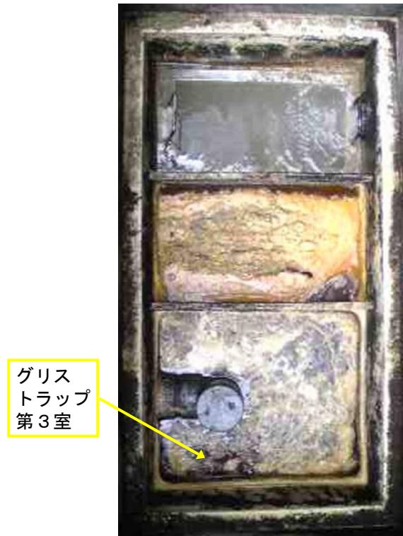
図 6 - 11 実証対象機器の設置前におけるグリストラップの状況
