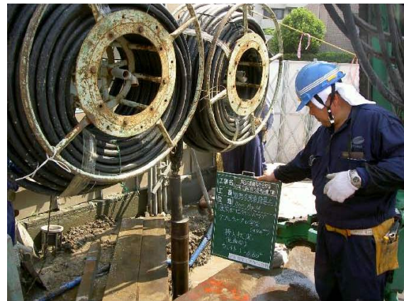
図 3-1 熱媒循環部（U字管）（左写真）及び熱媒循環部挿入状況（右写真）
