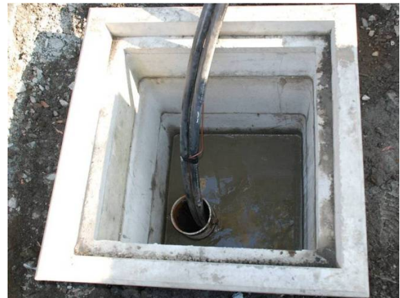
先端閉塞の回転貫入鋼管杭の頭部にコンクリート製枠を設置し、鋼管杭内部に循環水パイプ（ポリエチレン製）を挿入
