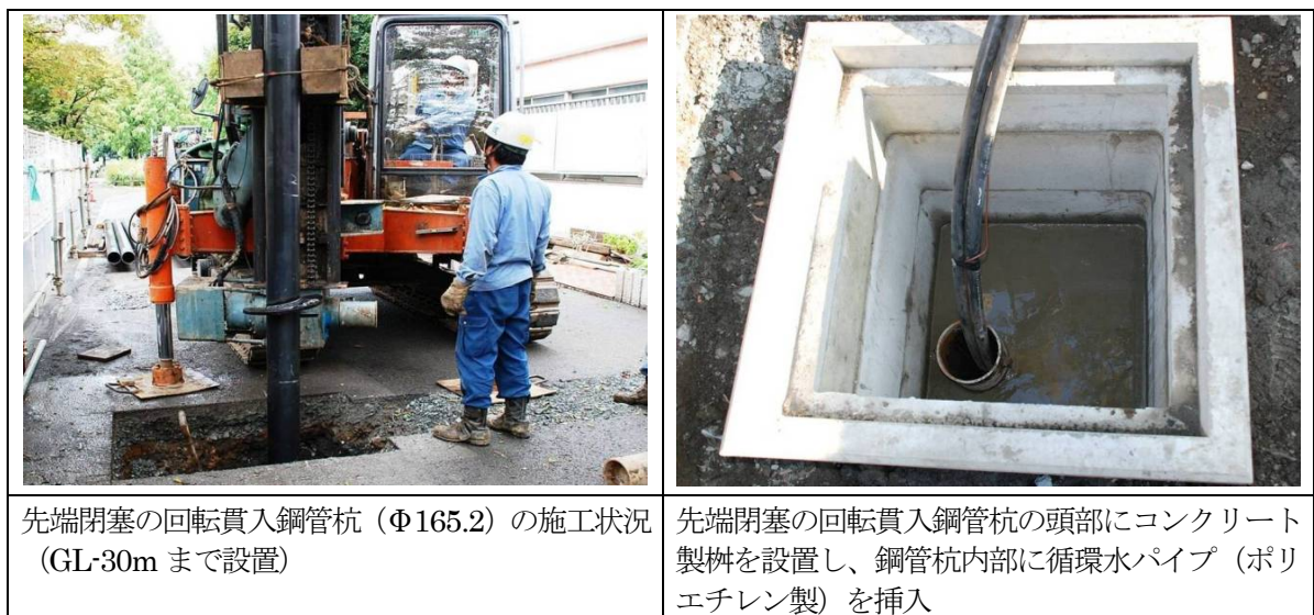
図 3-2 先端閉塞の回転貫入鋼管杭の施工時及び設置後の写真
