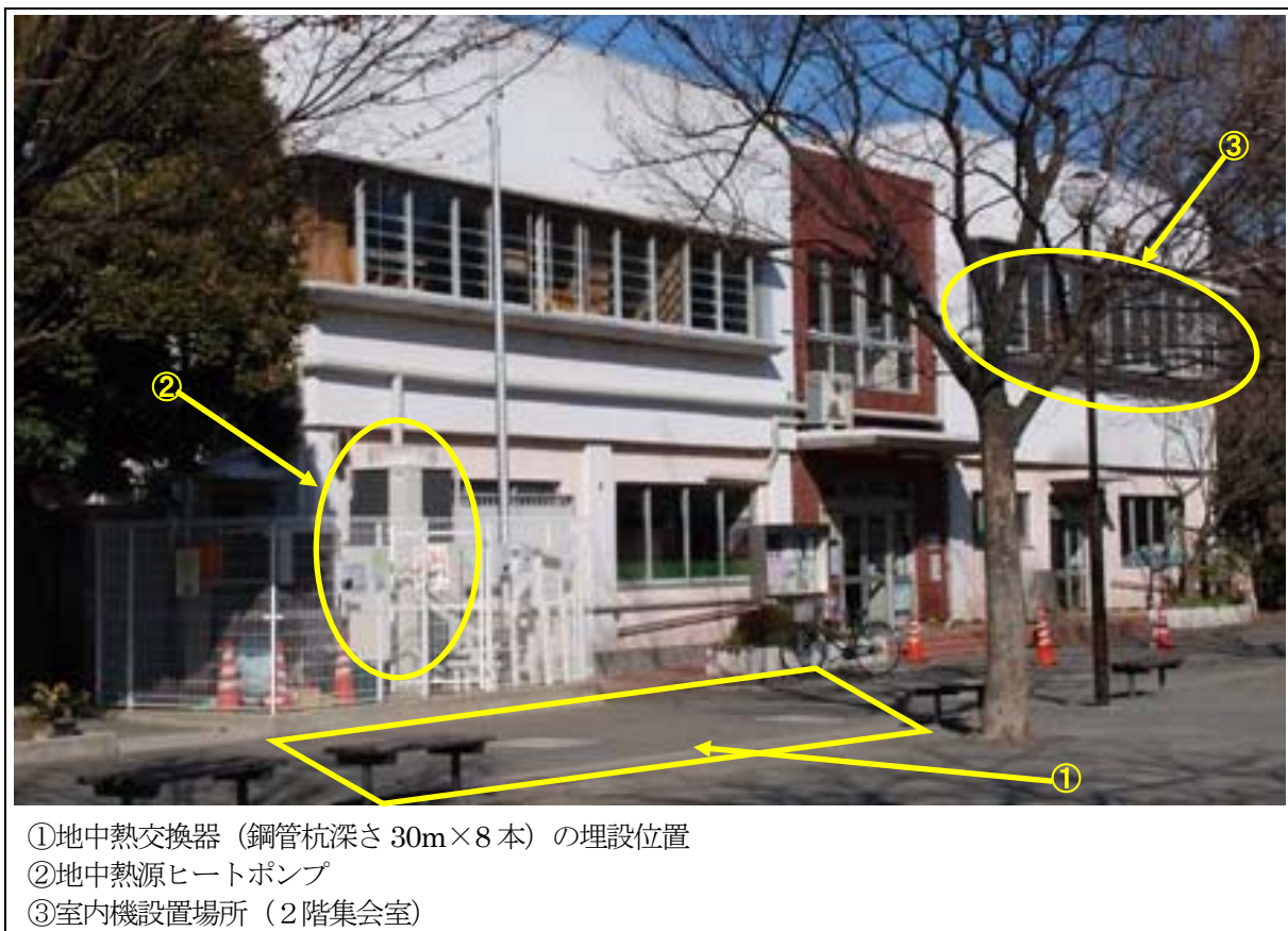
図 4-2 対象技術が設置された「川崎市 南河原こども文化センター」（実証試験実施施設）外観
