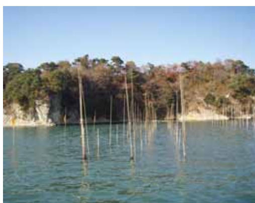
実証施設（J1）岸側方向を望む
