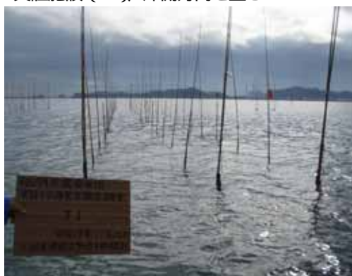
実証施設（J1）沖側方向を望む
