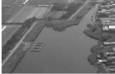
図-1 実証試験実施場所における隔離水塊の設置状況
