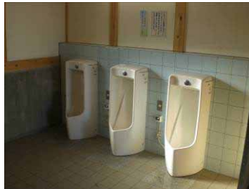
トイレ内部(男性用)
