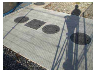
沈殿分離槽(埋設)
