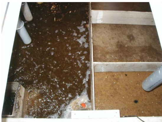
写真6 受入槽（左）、貯留槽（右）
