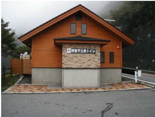
写真1 正面 トイレ入口
