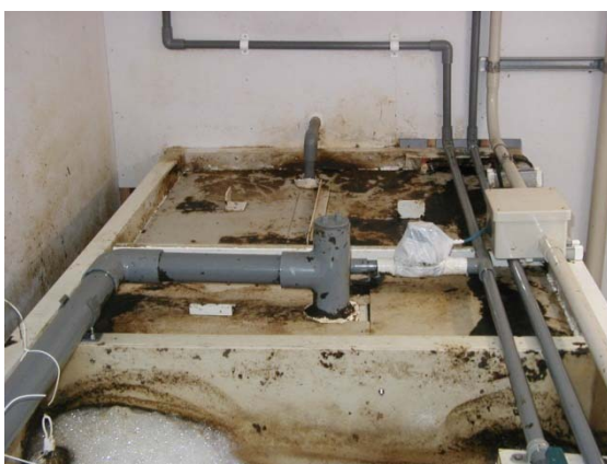
写真9 分離槽、送水槽
