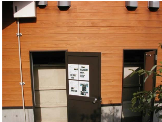
写真2 裏側 処理室入口
