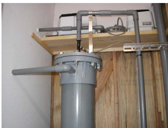
写真10 オゾン反応塔
