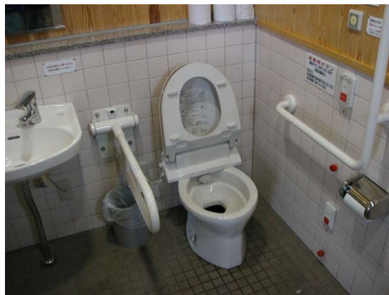
写真4 多目的トイレ 大便器（洋式）
