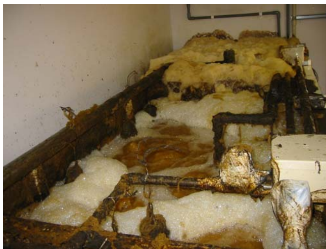
写真 6-6-1-1 発泡状況 手前：流動接触槽、 奥：分離槽・送水槽
