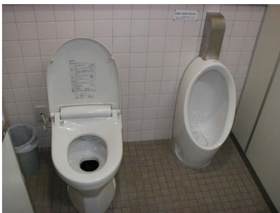
写真5 女性用トイレ 大便器 子供用小便器
