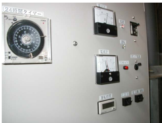
写真11 オゾン発生器 配電盤
