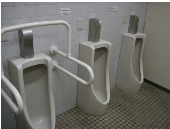
写真3 男性用トイレ 小便器
