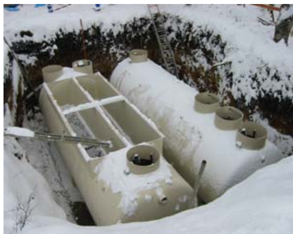
[高度処理・汚泥処理ユニット設置状況]
