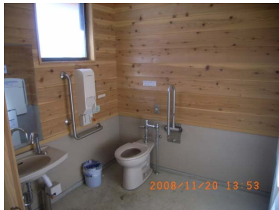
写真6 多目的トイレ 大便器（洋式）
