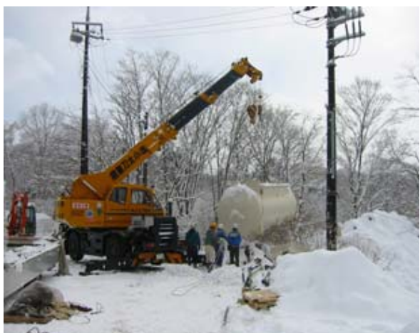
[高度処理・汚泥処理ユニット設置状況]
