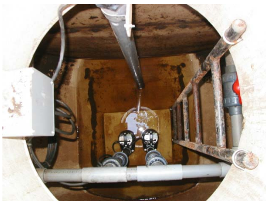
写真11 流量調整槽
