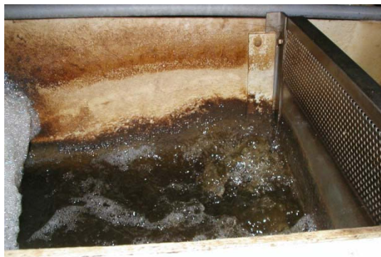
写真8 前処理槽 ばっ気式水中スクリーン前
