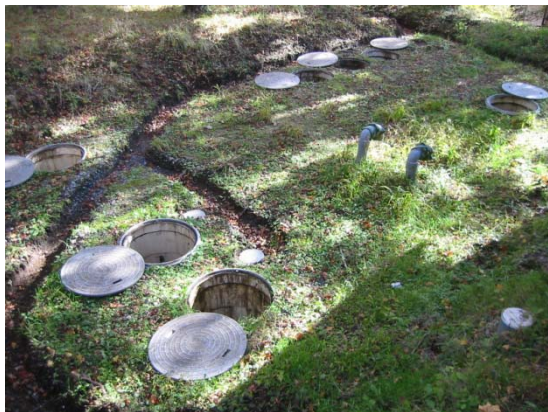
写真 13 高度処理ユニット・汚泥処理ユニット上部
