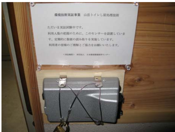
[カウンターの設置状況]
