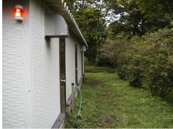
写真2 裏側 処理室入口
