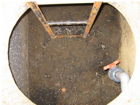
写真 14 軽石、土壌処理槽
