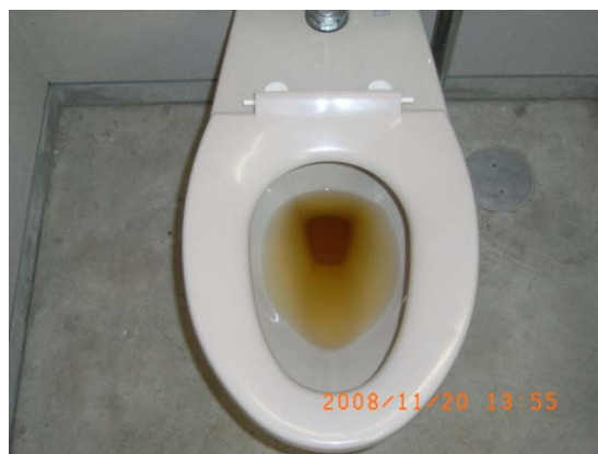
写真4 個室トイレ 大便器（洋式）
