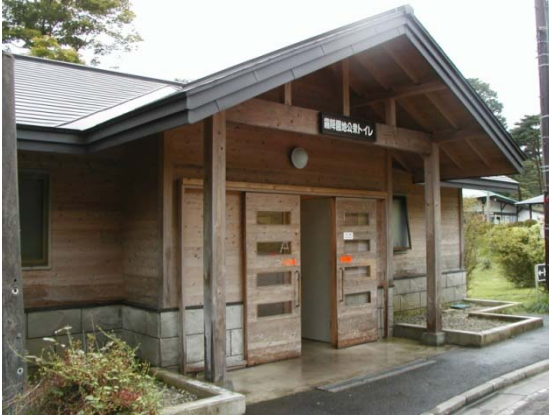
写真1 正面 トイレ入口
