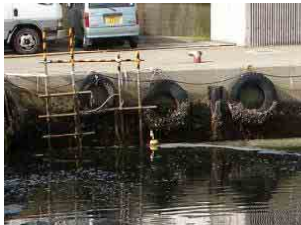
装置2設置状況(海底上0.5m固定式)
