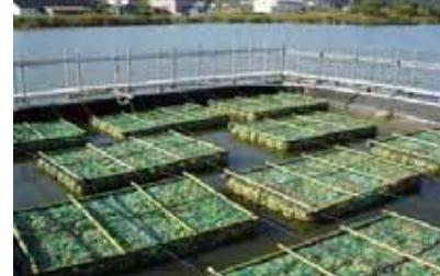
図-2 隔離水塊に設置した処理装置浮島
