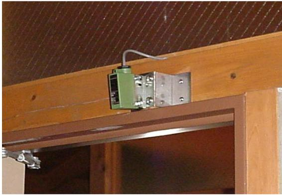
センサー部 (OMRON VF-D1000T)
