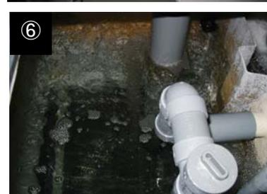
①トイレ外観 ②トイレ室内 ③処理装置外観 ④沈殿分離室 ⑤第1接触ばっ気室 ⑥オゾン接触室
