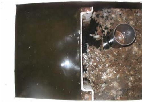
写真8 沈殿分離室
