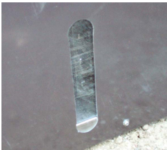
図 5-7 分離液点検箇所
