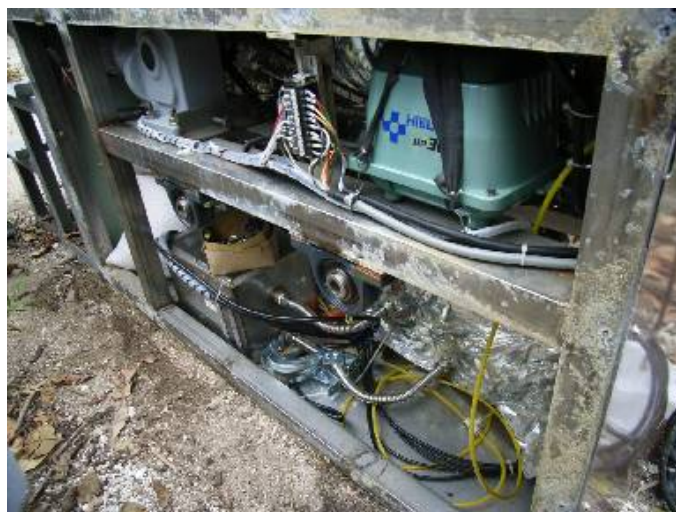
図 5-8 下部槽の清掃口
