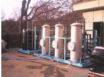
図 装置設置状況
