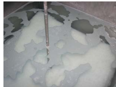
図 凝集沈殿槽における汚泥沈殿の様子
