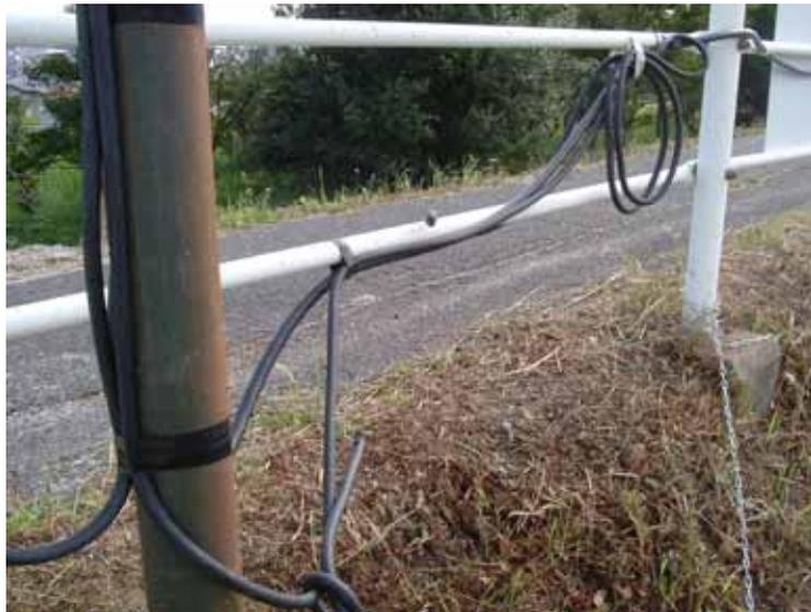
写真4 - 2 実証対象機器への電力供給配線の切断状況
