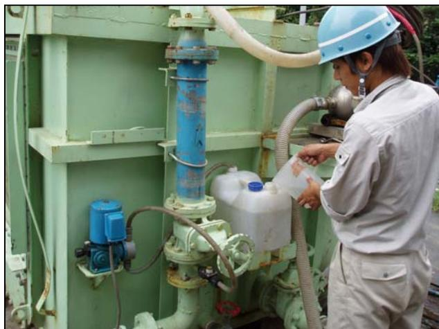
なお、薬注ポンプに液不足によりエアが混入した場合は、写真のように呼び水をホースに注入してから、薬液タンクにホースを差込み、エア抜きして運転を行ってください。
