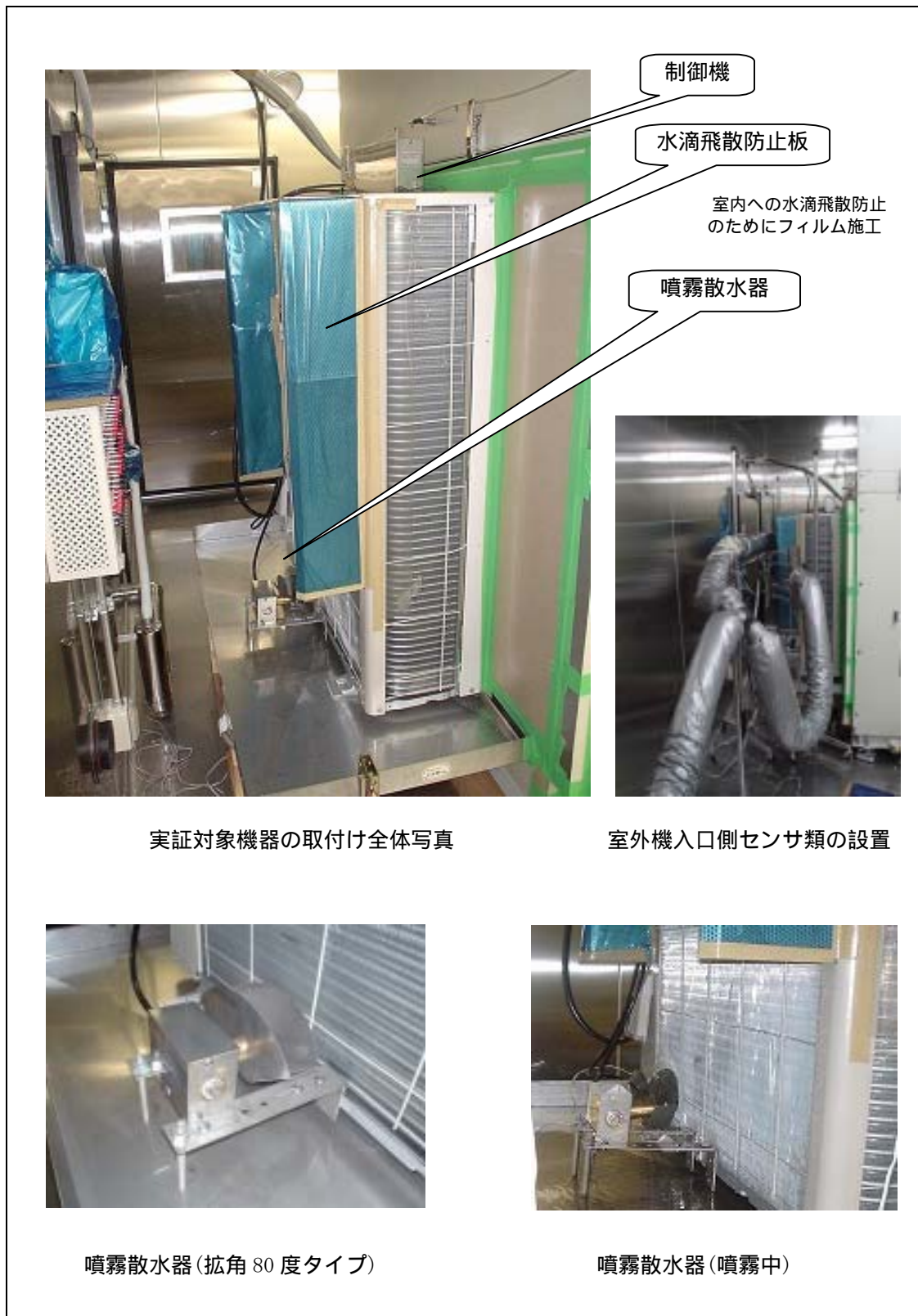
図 1 - 2 実証対象機器の設置状況
