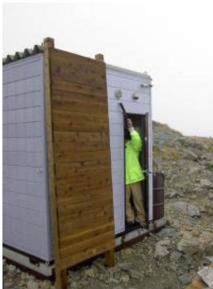
トイレ機械室部分
