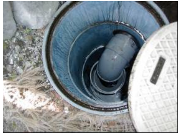
雨水調整槽（土壌処理槽内）
