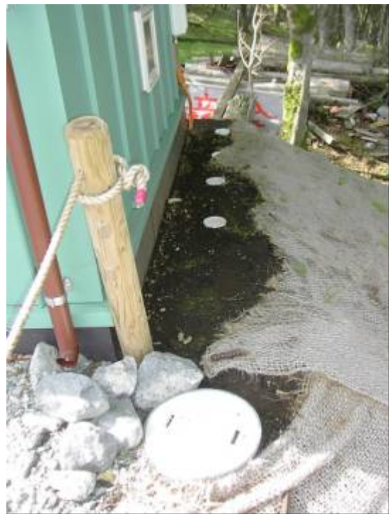
接触消化槽マンホール （左写真の反対側から撮影）
