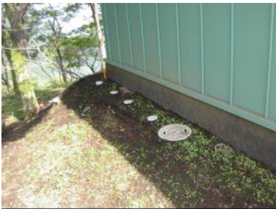
接触消化槽（建物裏）
