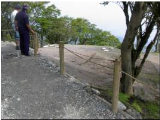
右側が土壌処理槽
