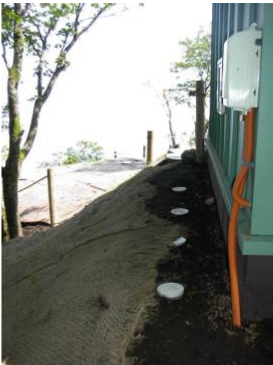
接触消化槽マンホール（建物横）
