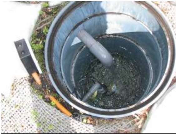
地下貯水槽（土壌処理槽内）
