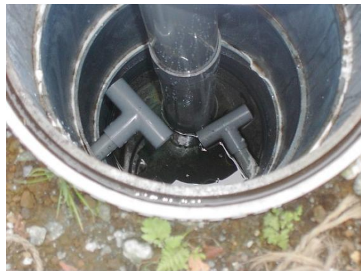
雨水調整槽内部の水位計
