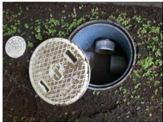
接触消化槽入口
