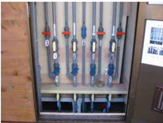
処理槽（送水室）
