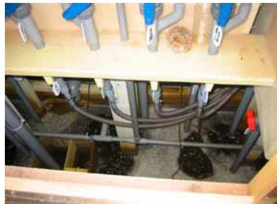
処理槽（流動攪拌室）
