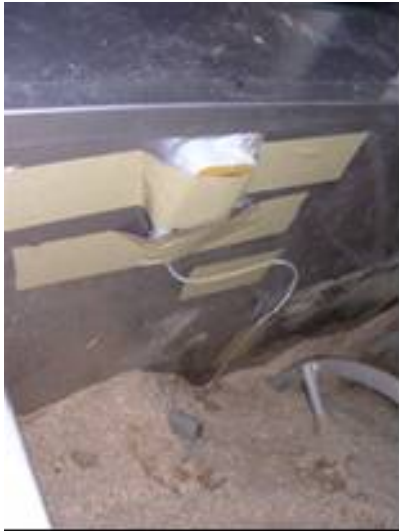
便槽内の温度センサー
