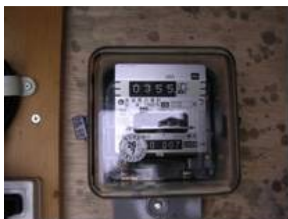
①電力量メーター
