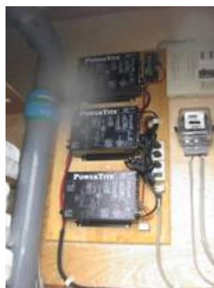
②電力量メーター
