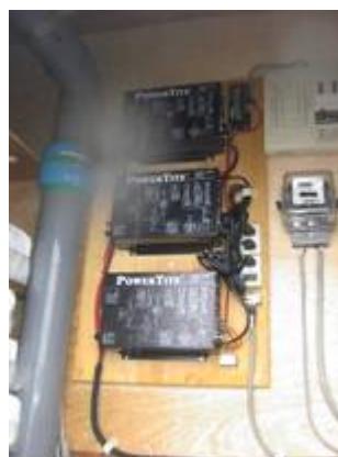
②電力量メーター
