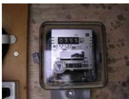
①電力量メーター
