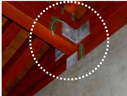
温湿度センサーの拡大写真
