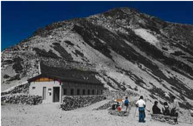
一ノ越公衆トイレ外観
