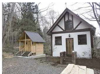
循環式し尿処理槽
