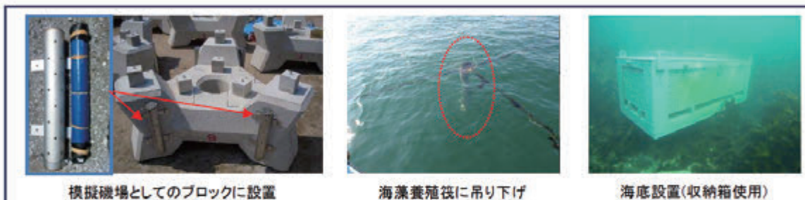
図 2 本実証対象技術の設置方法(例)
