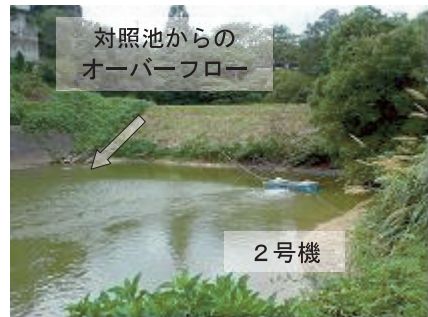
実証対象機器の設置状況
