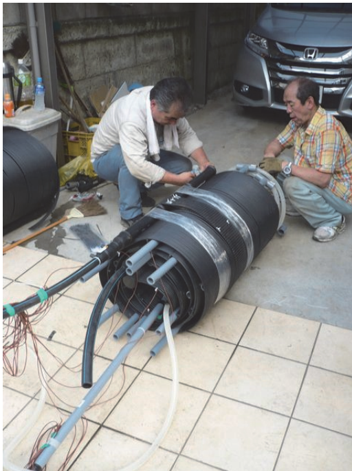
写真 2 シート状地中熱交換器 (G-カーペット)
