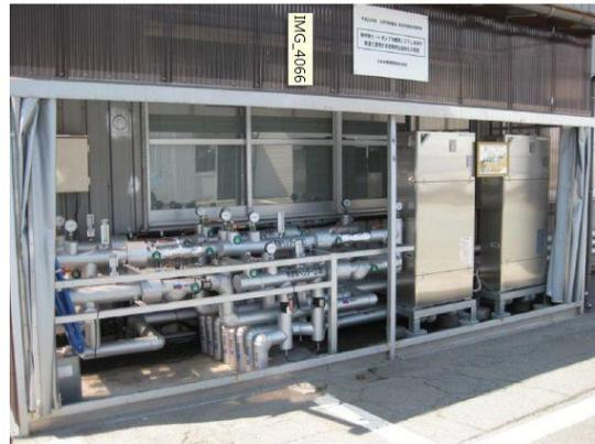
写真3 ヒートポンプと配管、計測器
