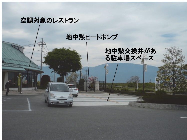
写真1 実証対象技術の全景
