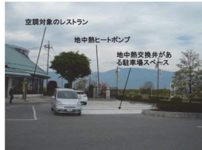
写真1 実証対象技術の全景
