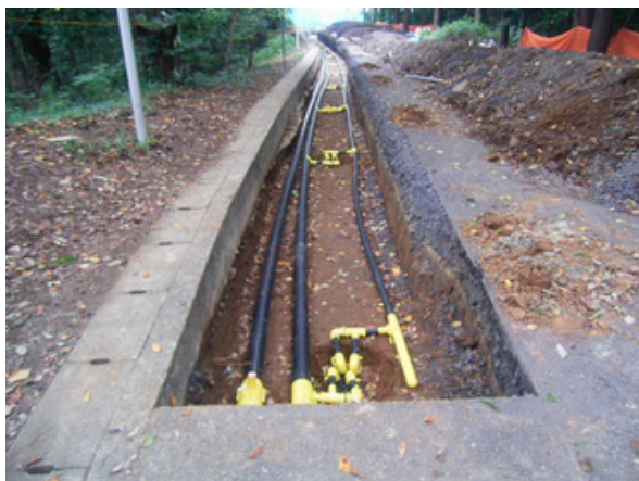
地中熱交換器設置状況
