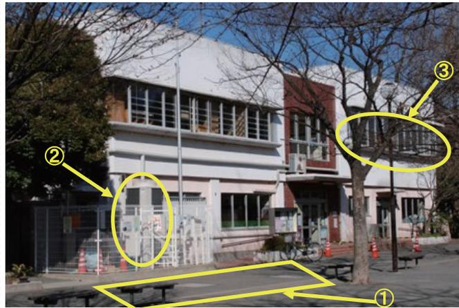
①地中熱交換器 (鋼管杭深さ 30m×8 本) の埋設位置
