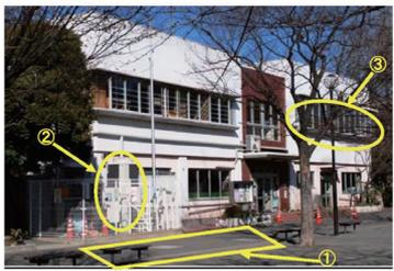
①地中熱交換器 (鋼管杭深さ 30m×8 本) の埋設位置
