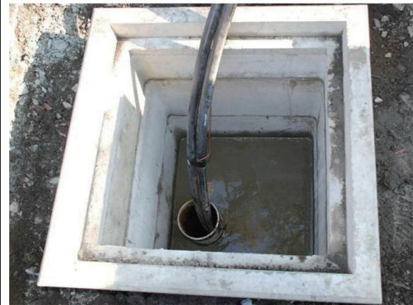
先端閉塞の回転貫入鋼管杭の頭部にコンクリート製柵を設置し、鋼管杭内部に循環水パイプ (ポリエチレン製) を挿入
