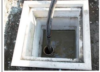
先端閉塞の回転貫入鋼管杭の頭部にコンクリート製樹を設置し、鋼管杭内部に循環水パイプ (ポリエチレン製) を挿入
