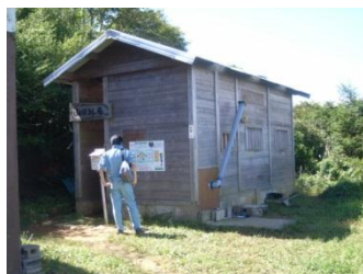
①トイレ全景
