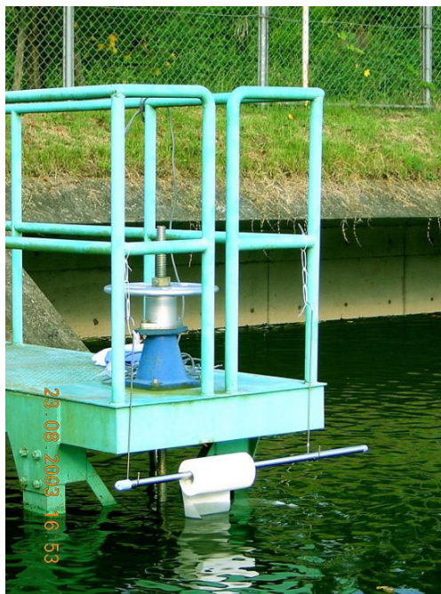
紙シートの尾張敷設
