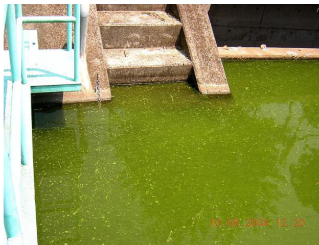
アオコで汚濁した池
