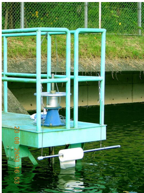
紙シートの尾張敷設
