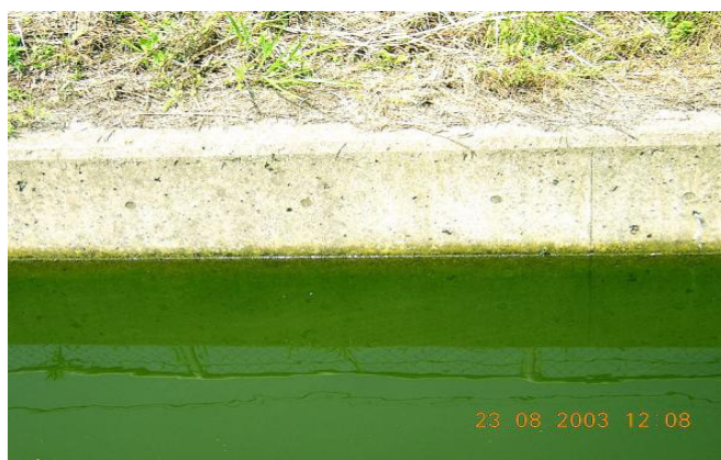
アオコで汚濁した池
