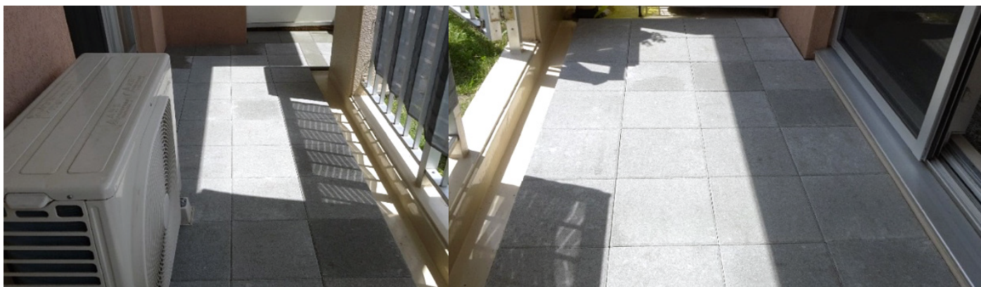
写真2 神奈川県某所における施工完了後の風景
