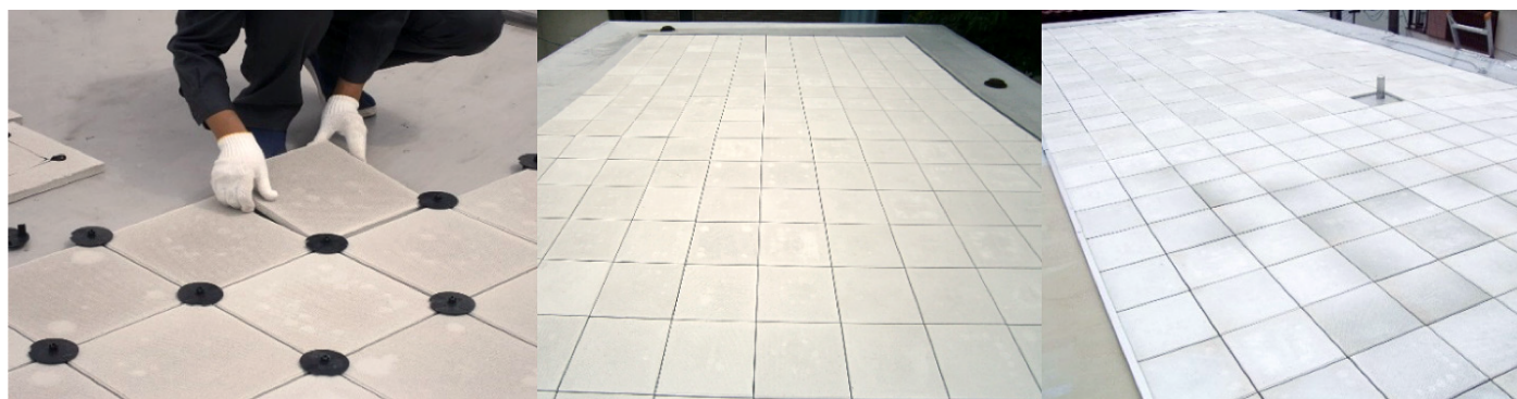
写真1 埼玉県某所における施工完了後の風景
