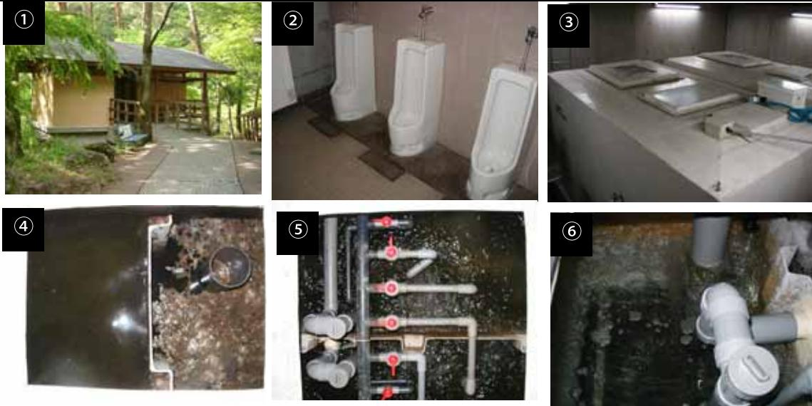
①トイレ外観 ②トイレ室内 ③処理装置外観 ④沈殿分離室 ⑤第1接触ばつ気室 ⑥オゾン接触室
