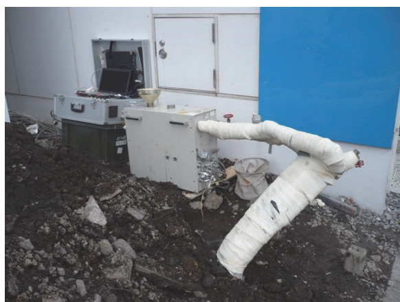
写真5 保温材を巻終った状況
