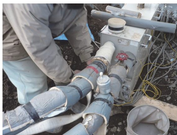
写真4 配管に保温材を巻く作業
