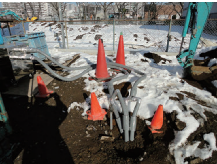
写真 4 配管の保温後の接続状況
