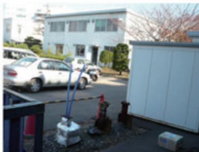
写真2 U字管を挿入し、H形鋼の露出部分を保温した状況
