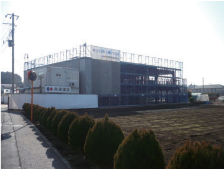
写真1 きらめき保育園工事現場全景
