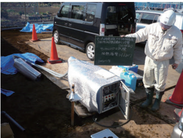
写真3 配管及び装置の保温を行った後、加熱循環を開始
