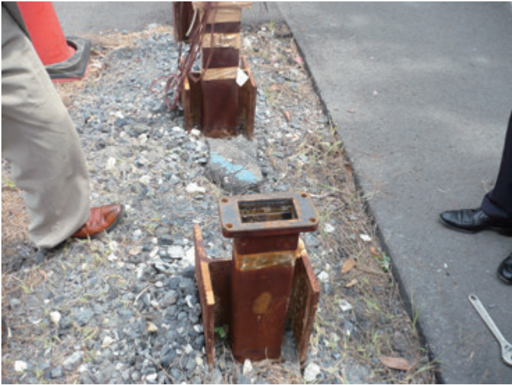
写真1 ソイルセメント杭に挿入されたH形鋼と保護管 （ソイルセメントそのものは、砂利の下になり、見えていない。）
