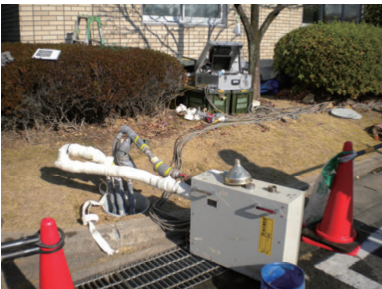
写真3 配管の保温後の接続状況、試験装置の制御装置は奥の方に設置している。
