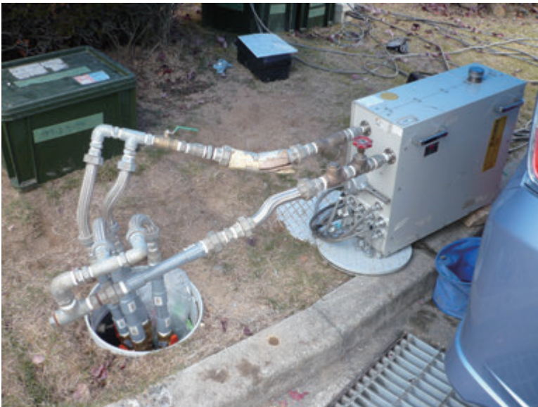
写真2 ダブルU字管や配管と試験装置の保温前の接続状況
