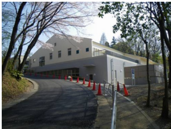
屋内プール棟の外観
