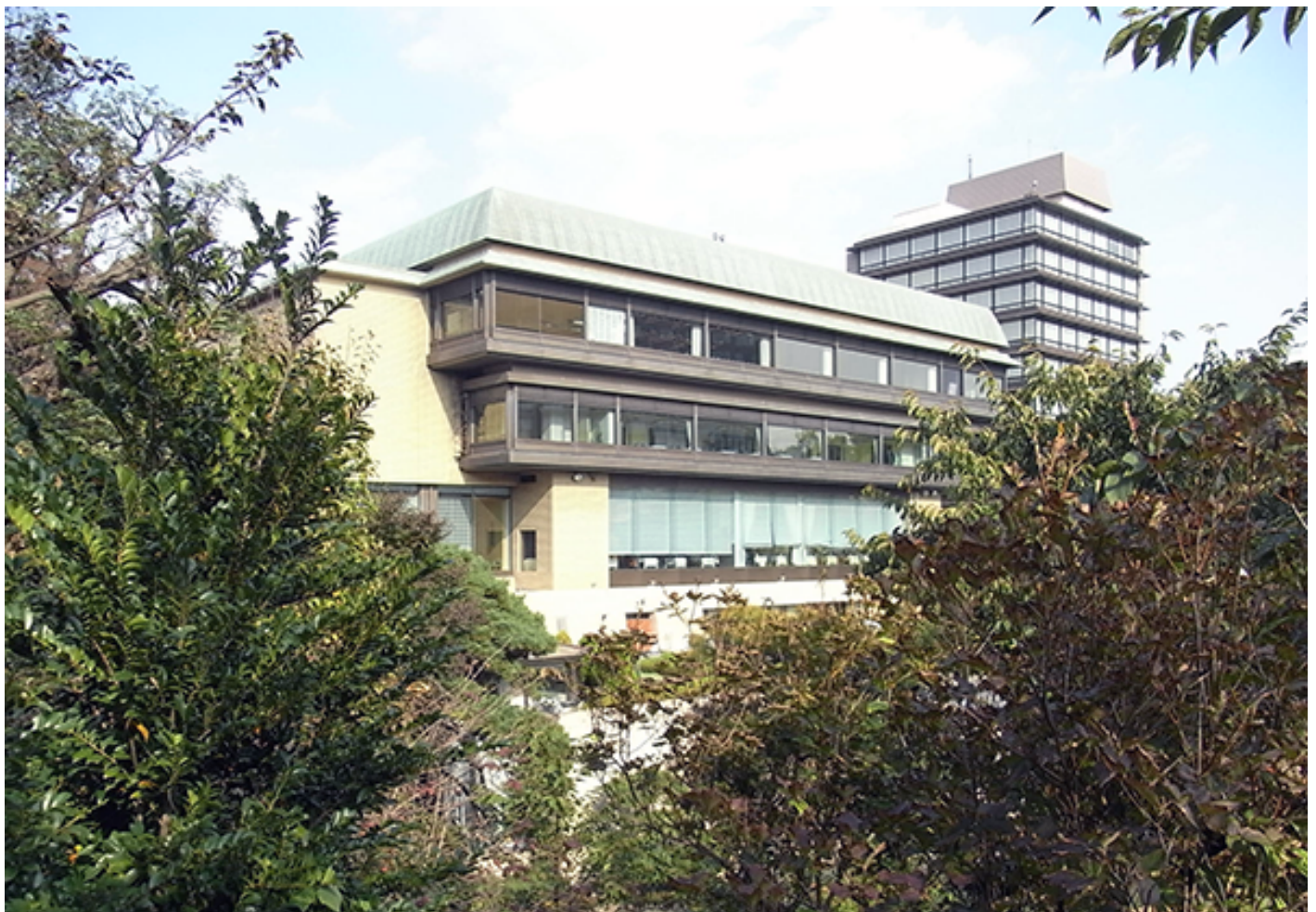
写真1 藤田観光株式会社 椿山荘の窓ガラス
