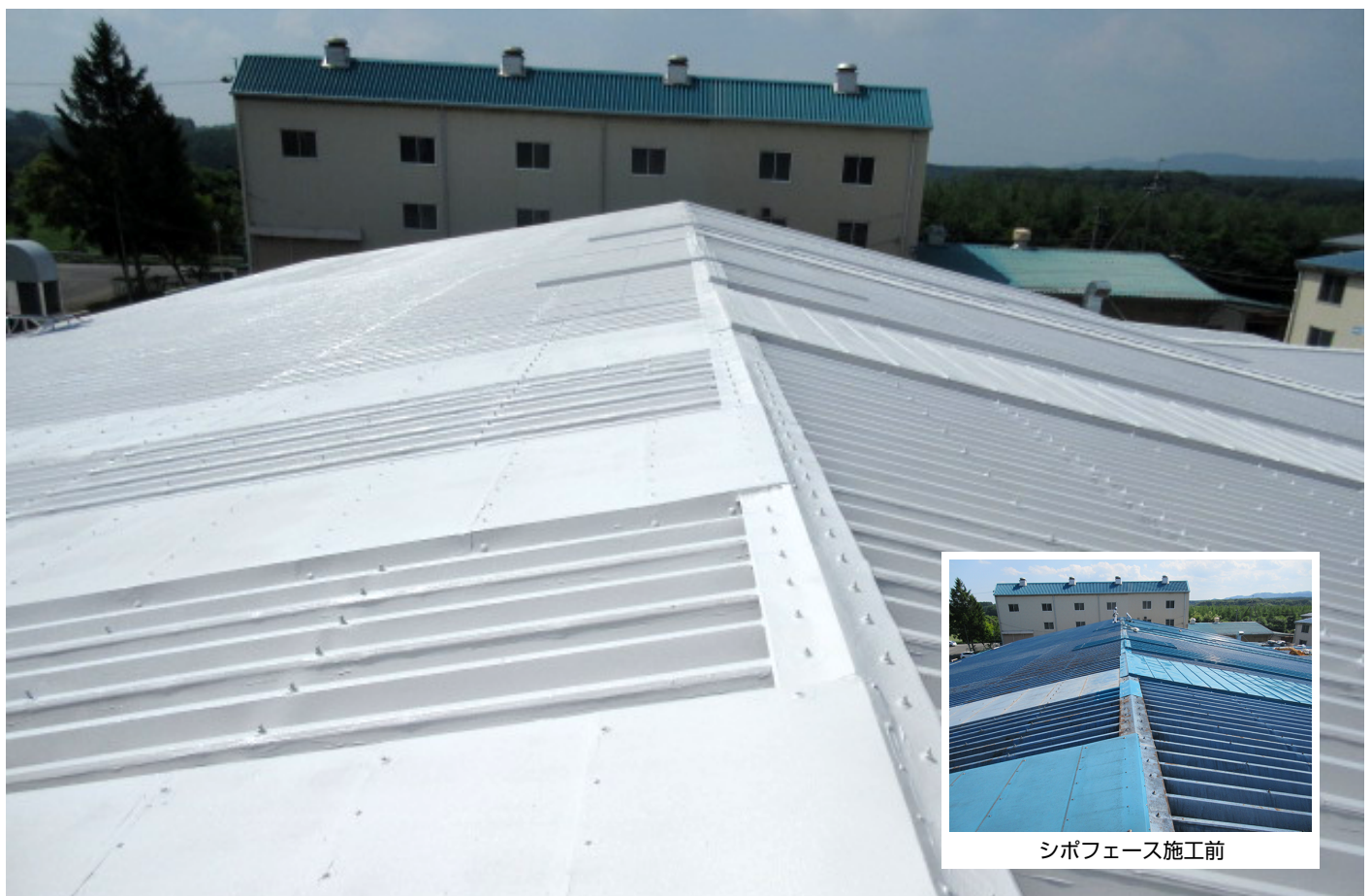
写真1 シポフェース施工後の屋根の外観
