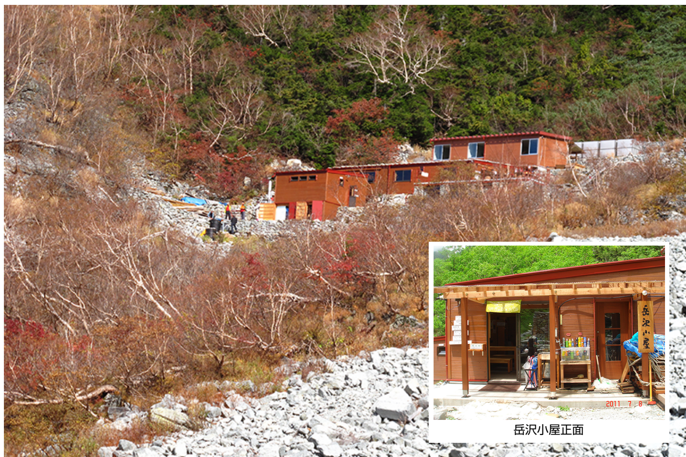
写真1 長野県北アルプス岳沢小屋
