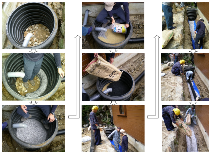
図3 し尿処理施設毛管浄化工施工風景
