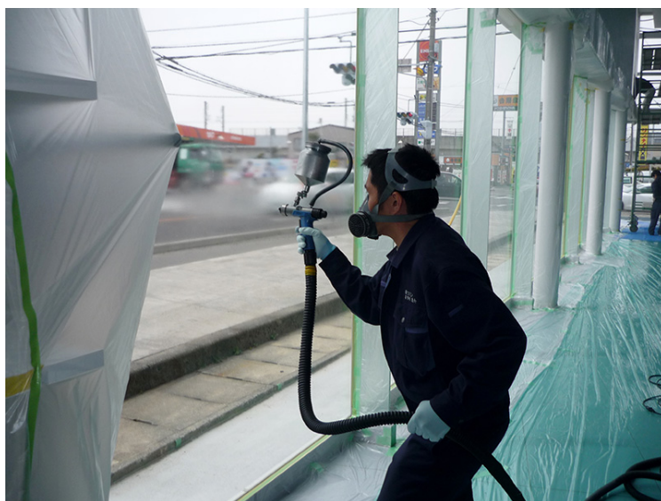
写真3 フミンコーティングのスプレーによる吹きつけ（特許技術）
