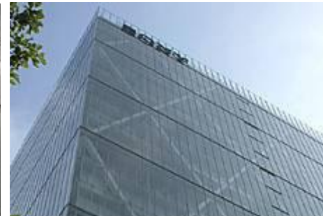
「ダブルスキン」が採用された外壁
