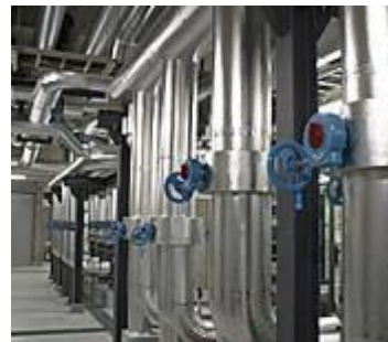
ソニーシティ空調用冷却水システム
