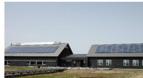
<太陽光発電設備>
