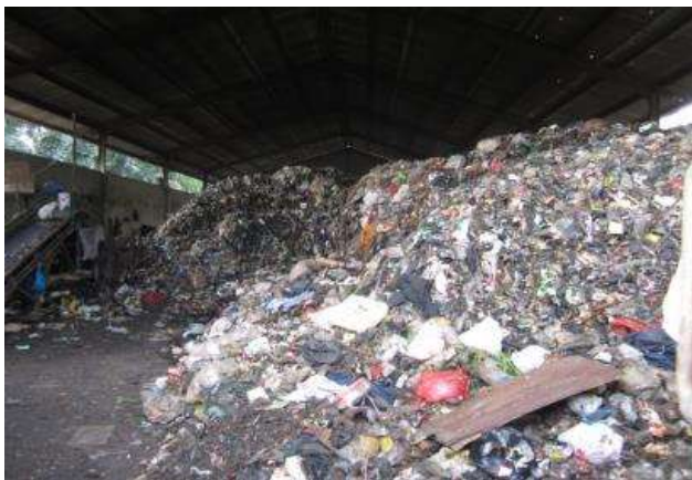
指導前の堆肥化施設。 廃棄物が混載状態で搬入されていた。
