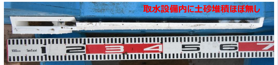
写真 通水後のチロル内の土砂堆積状況(上：排砂ゲート無、下：排砂ゲート有)
