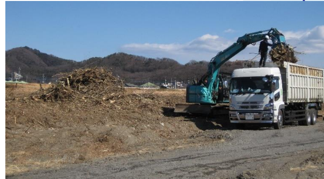
図 チップ化用以外の河道内樹木の積込の様子
